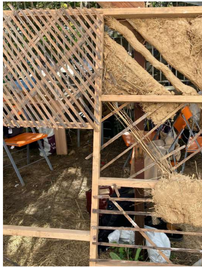
Chantier étudiant en torchis à Paris avec Landfabrik
