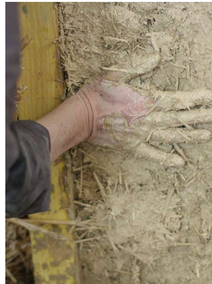
Test de torchis et d'enduit
